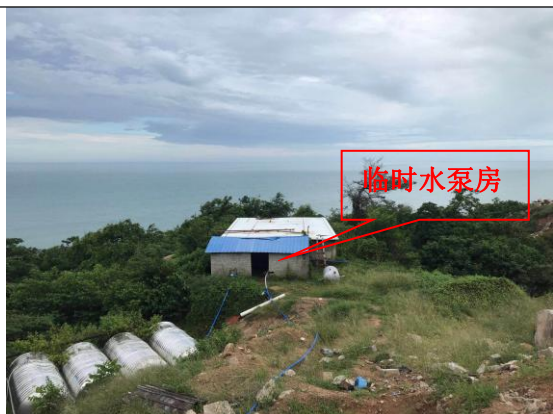
照片 11 临时水泵房
