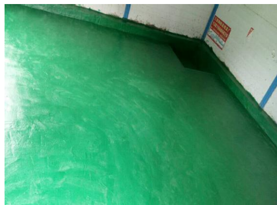
照片 14 垃圾房防渗漏地板
