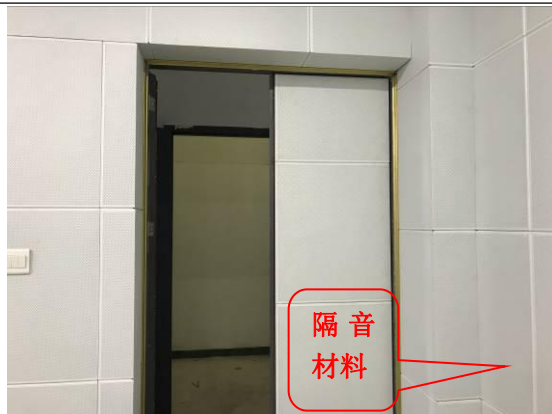
照片 3 发电机房墙壁上隔音材料
