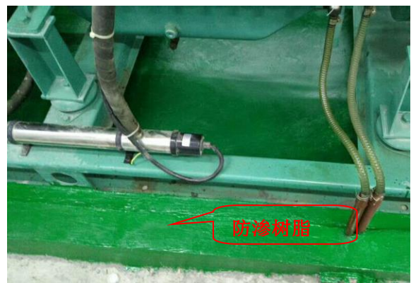
照片 4 发电机室地面防渗层
