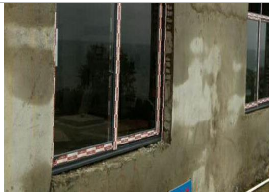
照片 16 污水处理站
